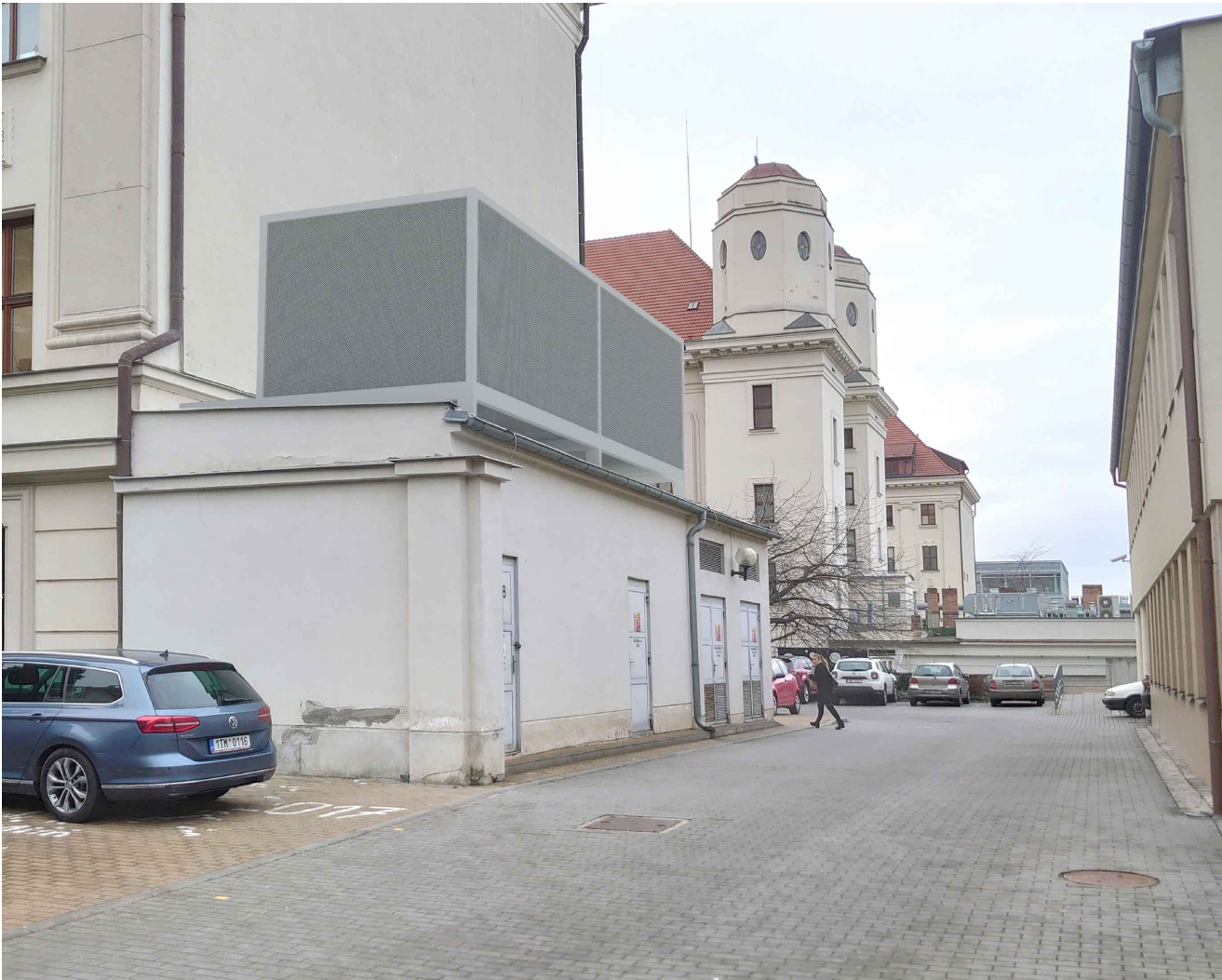
KONSTRUKCE PRO VENKOVNÍ JEDNOTKY - UMÍSTĚNÍ NA TRAFOSTANICI U VÝCHODNÍHO KŘÍDLA OBJEKTU A
